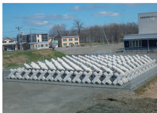
大空町 大空河川防災ステーション
