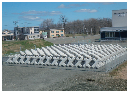
大空町 大空河川防災ステーション
