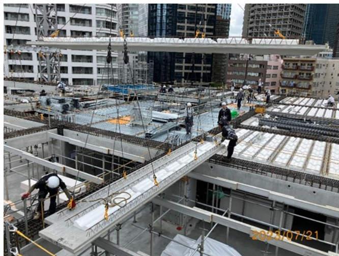
【写真2 適用対象(現場施工状況)】
