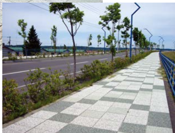
名寄市 日進橋歩道
