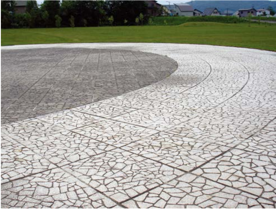
愛別町 愛別総合スポーツ公園 / 自然石張り
