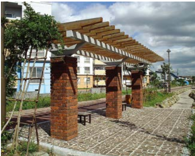
旭川市 永山一番線通り / 自然石張り
