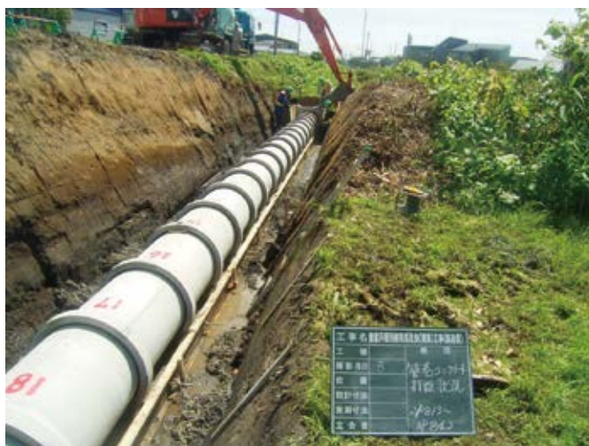
ヒューム管の施工状況 ：豊富浜頓別線
