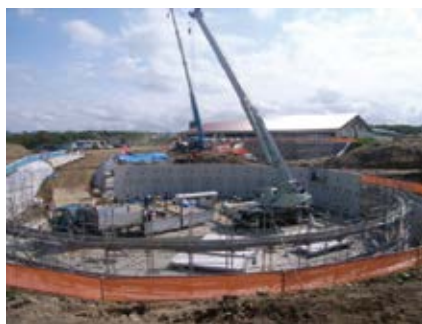
スラリータンクの施工状況
