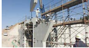
[2] 2段目ブロック据付
