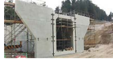
[3] ブロック据付完了
