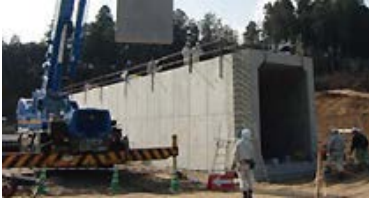
[1] 1段目ブロック据付
