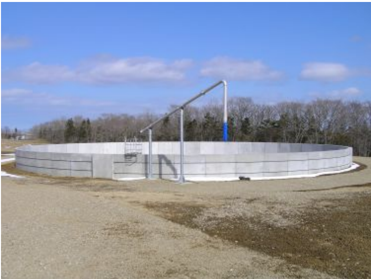
国営環境保全型かんがい排水事業 別海南部地区 \phi 32.3\text{m} 2,860\text{m}^3
