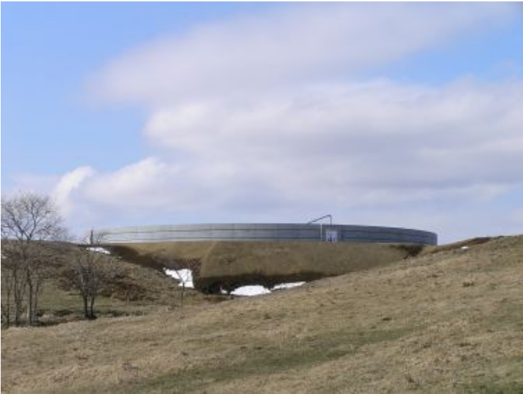
国営環境保全型かんがい排水事業 別海南部地区 \phi 36.6\text{m} 3,680\text{m}^3
