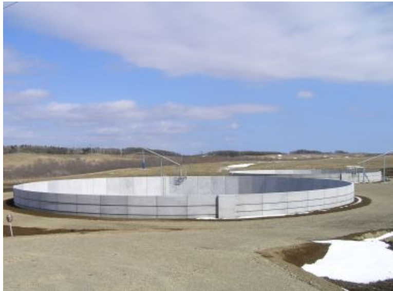
国営環境保全型かんがい排水事業 別海南部地区 \phi 33.1\text{m} 3,000\text{m}^3
